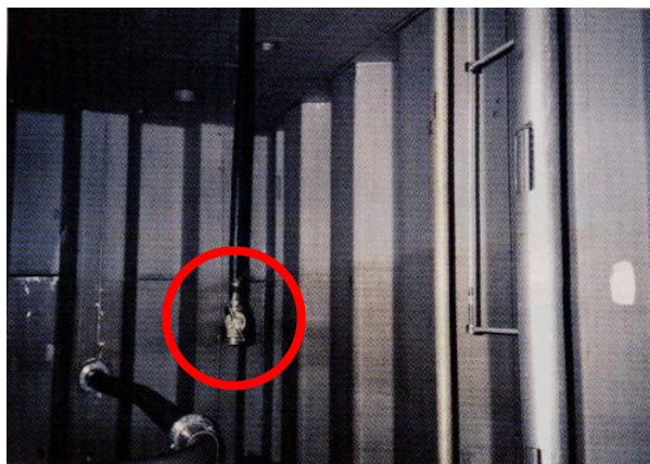
図 1.4 予備洗浄装置の船上ノズル
